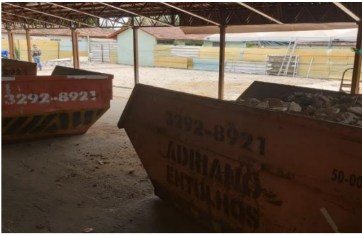
CIVV: Início da construção do salão de convivência, cozinha e pátio.
