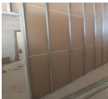
CIVV: Instalação de Drywall - Reforma do Almoxarifado e Criação da Sala de Gêneros Alimentícios e Reforma do Salão de Convivência, Cozinha e Pátio da Unidade (em andamento)
