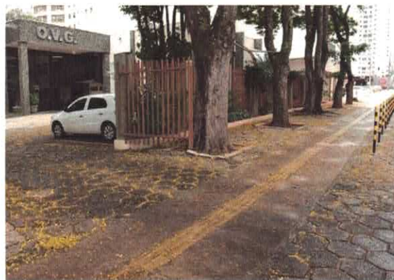
Execução do Piso Tátil na Sede da OVG
