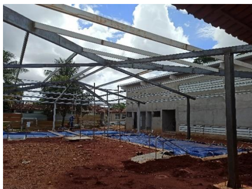
CIVV: Construção da cobertura da área das piscinas
