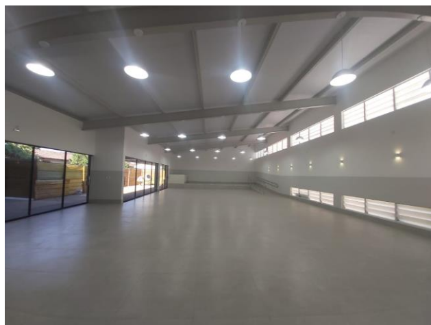
CIVV: Execução do Salão de Eventos
