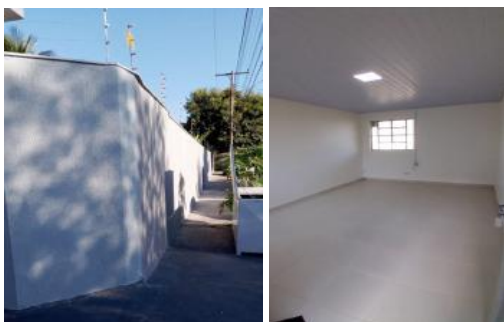
CIVV: Reforma do muro e sala da Psicologia
