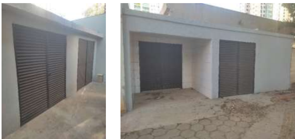
Finalização do abrigo de resíduo da Sede
