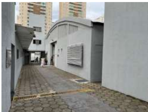
Pintura dos blocos
