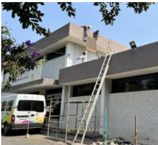
Reforma do telhado da unidade
