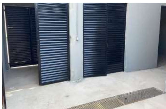
Finalização do abrigo de resíduo do CJTF
