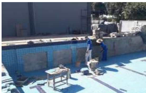
Construção da piscina
