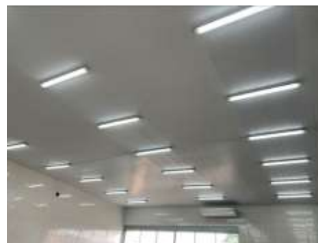
Forro e troca de luminárias
