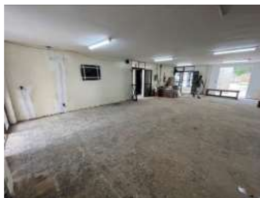
Reforma do Centro Dia
