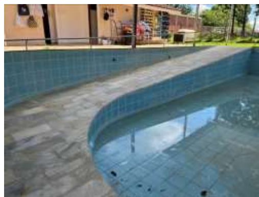
Troca de revestimento rampas
