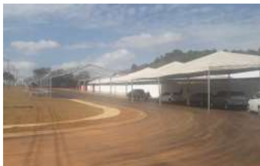
Montagem de Estrutura - CAR Trindade
