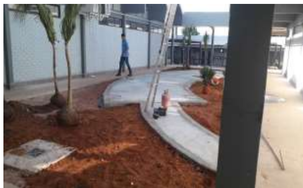
Execução de calçadas
