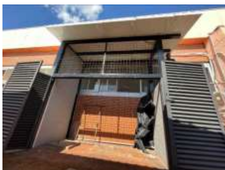
Construção de abrigo para compressores
