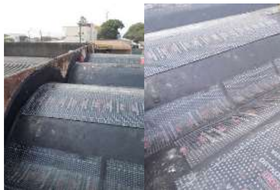
Impermeabilização do telhado
