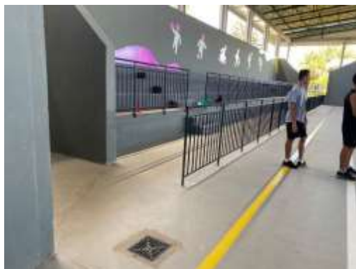
Reforma do ginásio
