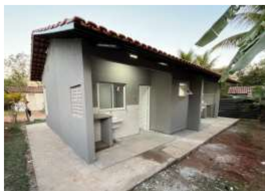
Reforma Geral, CISF - Casas Lares
