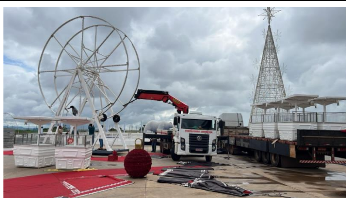
Desmontagem da Roda Gigante
