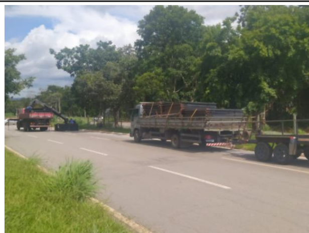
Desmontagem das estruturas dos estacionamentos
