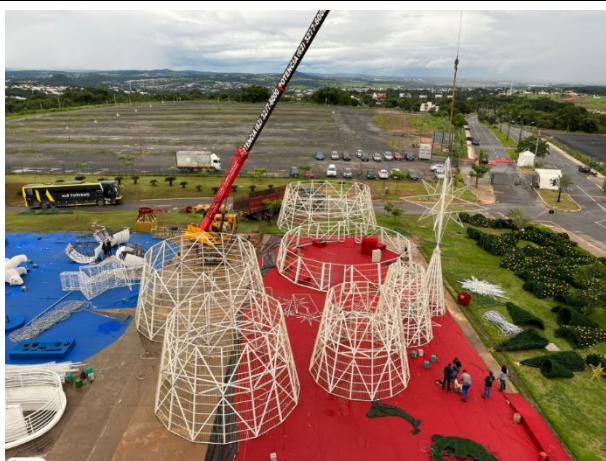
Desmontagem da Árvore de 40 metros
