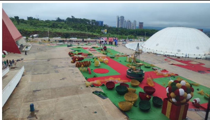
Desmontagem da estrutura da Vila do Papai Noel
