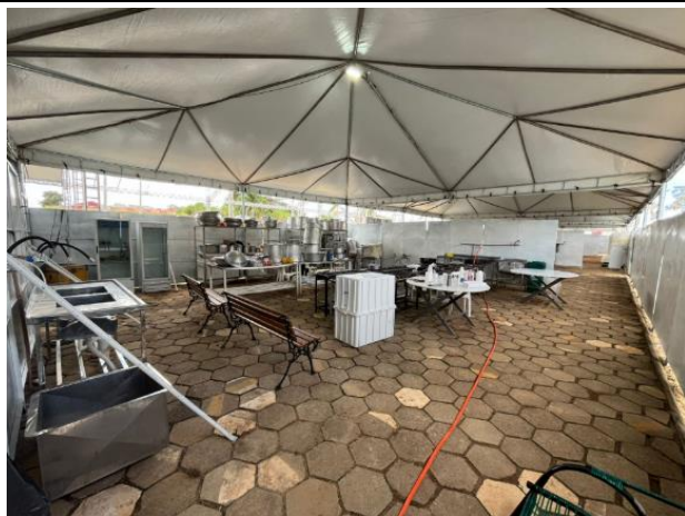
Início da montagem da estrutura da cozinha
