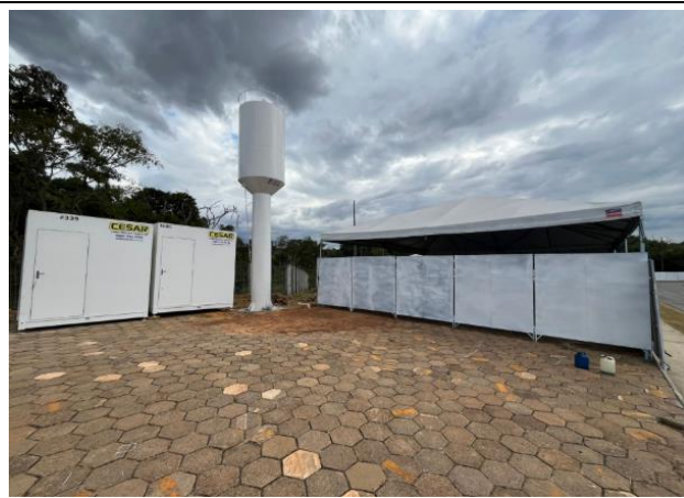
Montagem dos banheiros e instalação da caixa d'água
