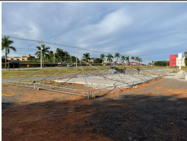
Montagem da estrutura em andamento
