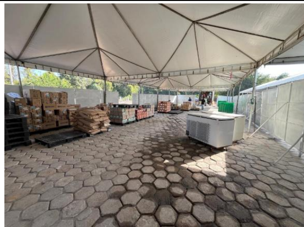
Estruturação do almoxarifado em andamento
