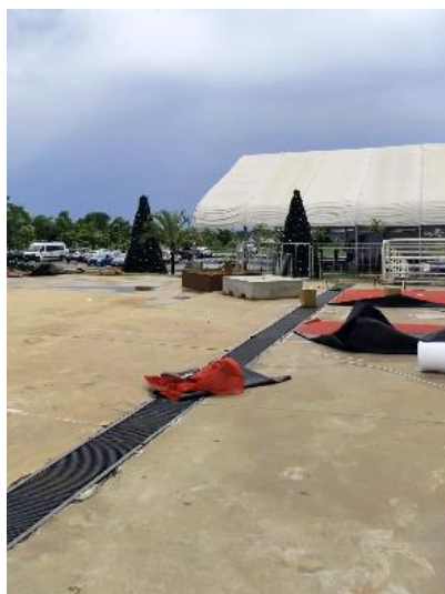
A imagem das treliças nuas sob o céu aberto e dos materiais empilhados ilustra a magnitude da infraestrutura necessária para realizar o evento
