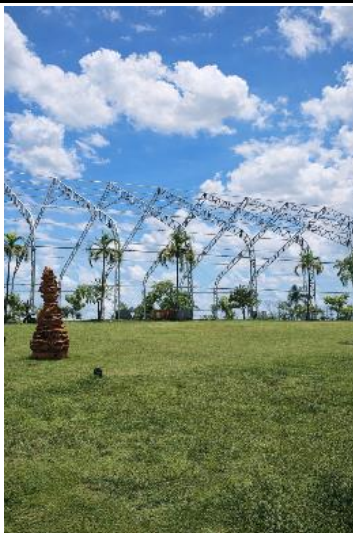
Com a retirada da cobertura, a estrutura revela a magnitude da engenharia por trás do Natal do Bem
