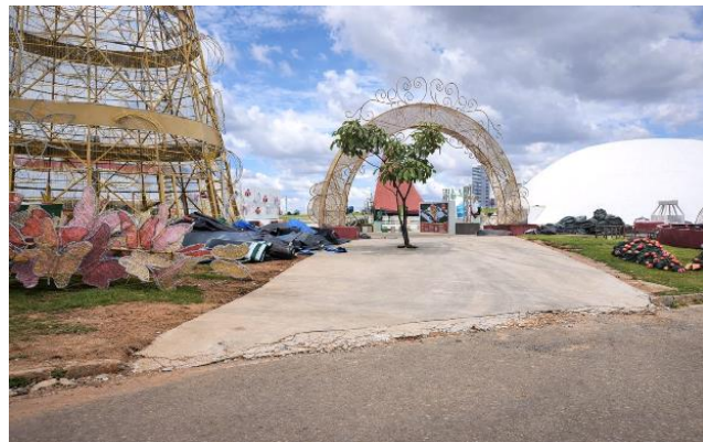
Fase de desmontagem e organização do espaço, garantindo a finalização adequada da estrutura
