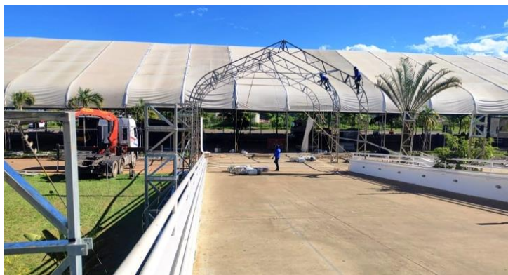
O "esqueleto" metálico da Tenda Cristal fica visível após a remoção da lona de cobertura
