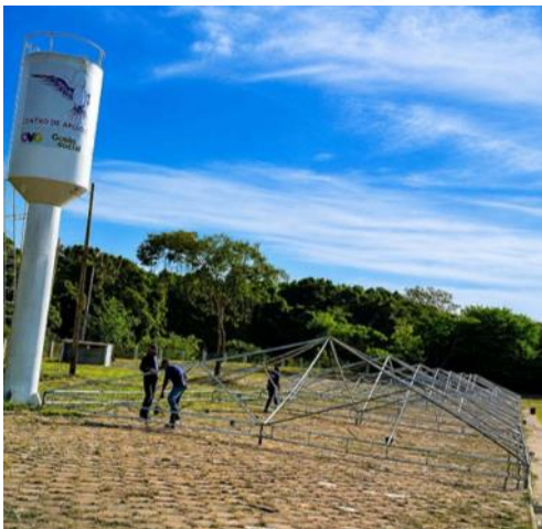
Início da montagem da estrutura do Centro de Apoio ao Romeiro de Trindade
